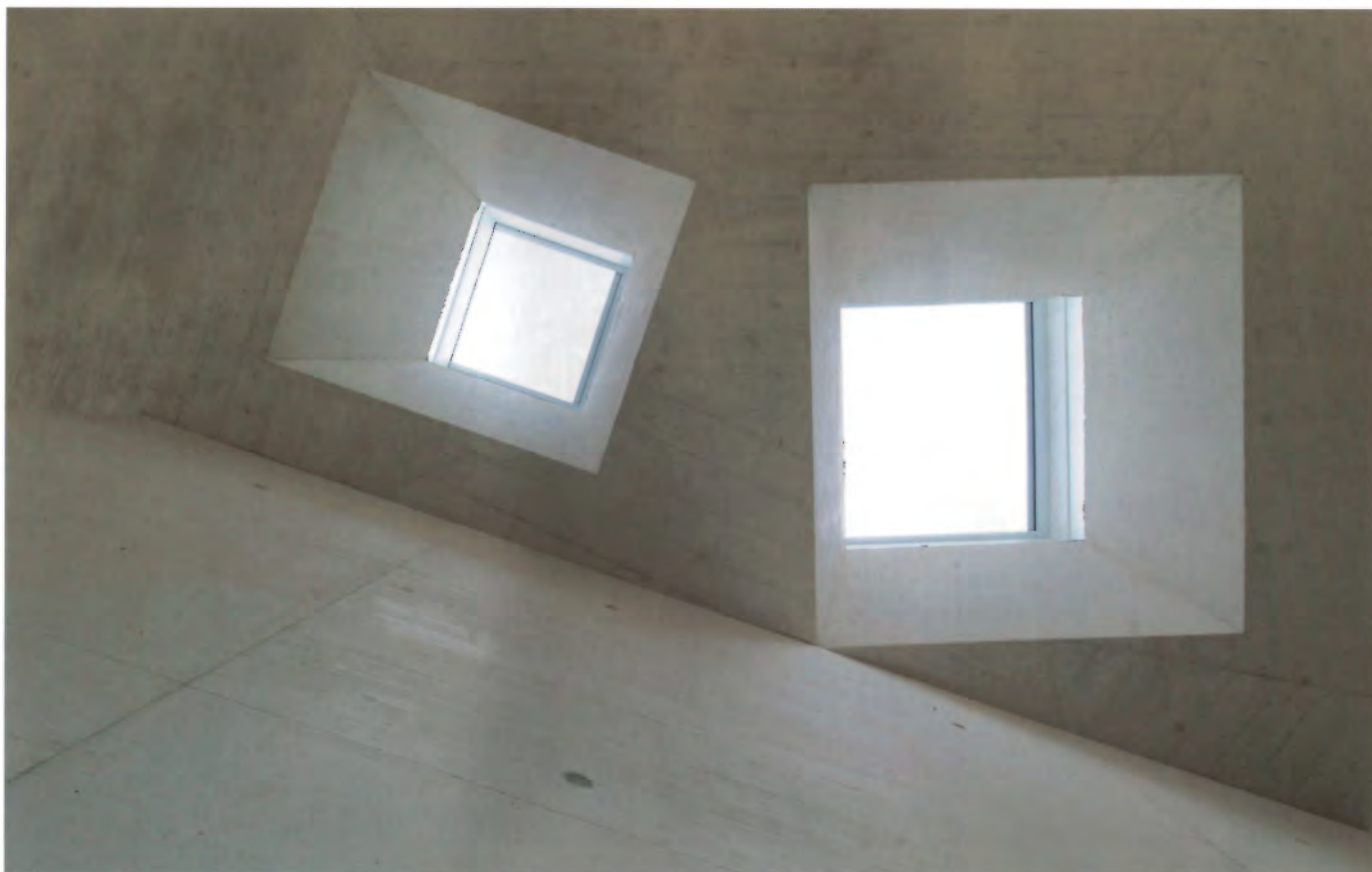
Die zueinander versetzten Oberlichter erzeugen optimale Lichtverhältnisse im Innenraum.
